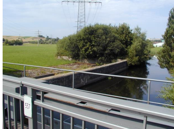
Bild Zustand vor dem Umbau
