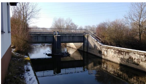
Bild Zustand nach Ausbau der Schütze 2017
